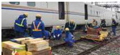
脱線復旧作業の様子
