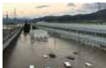
運転事務所からの全景 (2019年10月13日撮影)
