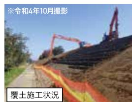
現在護岸ブロックの施工を行っているほか、ブロックの施工が完了した工事では覆土や植生工を行っています。
