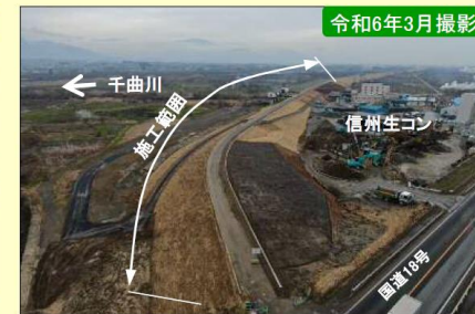
現地施工状況②
