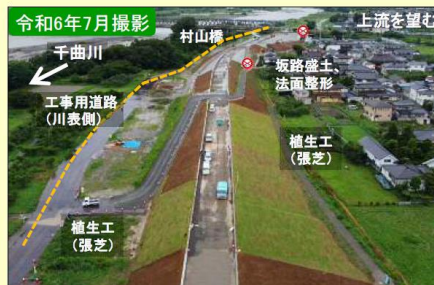
現地施工状況②
