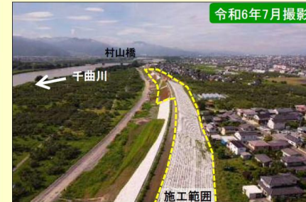
現地施工状況②
