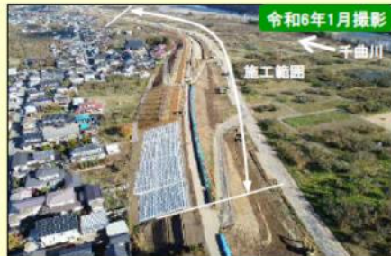
現地施工状況①
