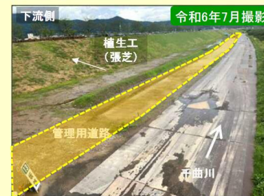
現地施工状況②
