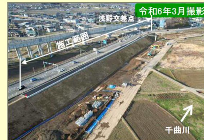
現地施工状況①
