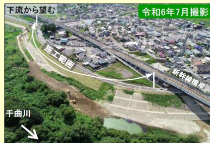
現地施工状況②
