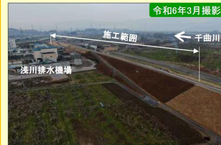
現地施工状況①
