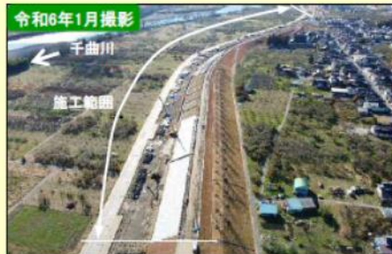
現地施工状況②
