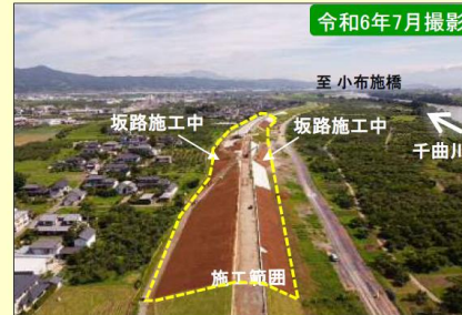
現地施工状況①
