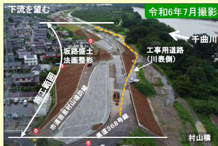
現地施工状況①
