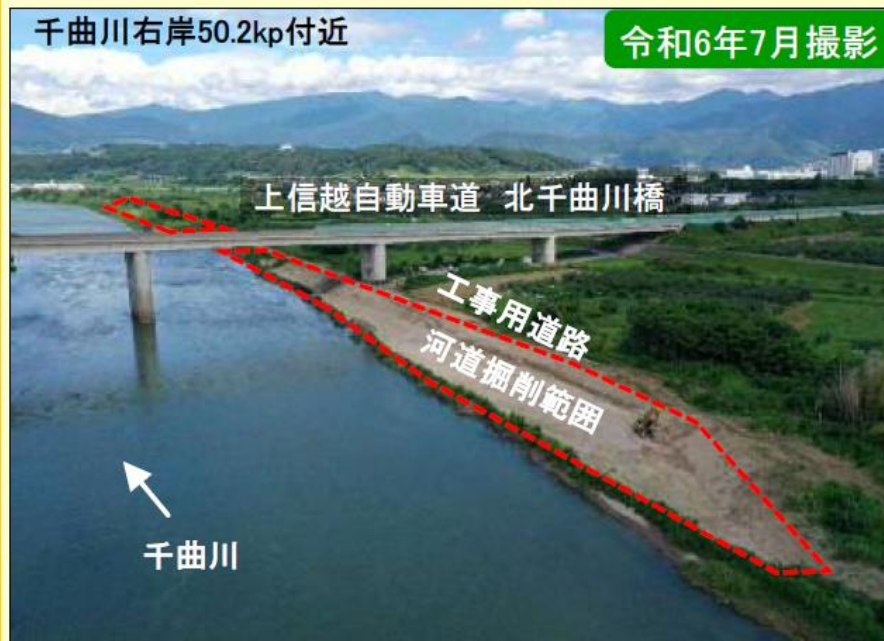
現地施工状況①
