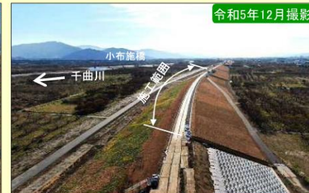
現地施工状況②
