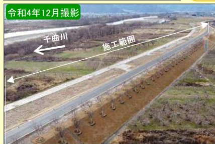
現地施工状況①
