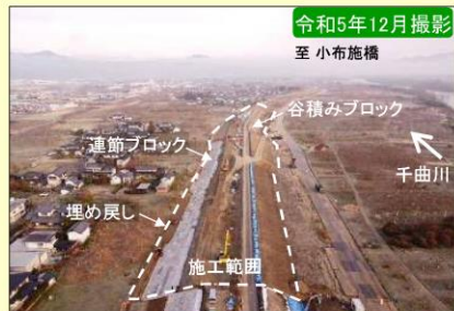
現地施工状況①
