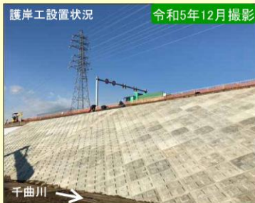
現地施工状況②
