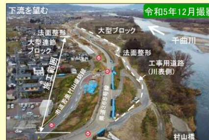
現地施工状況①
