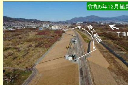
現地施工状況①
