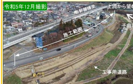
現地施工状況①
