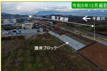
現地施工状況①
