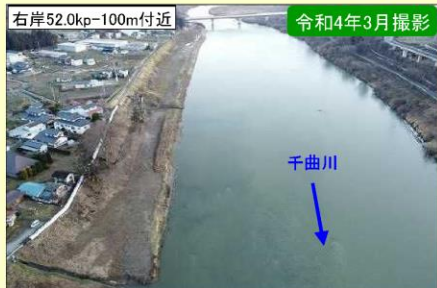
現地施工状況①
