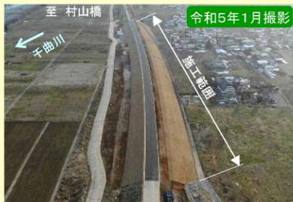
現地施工状況①
