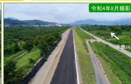
現地施工状況②
