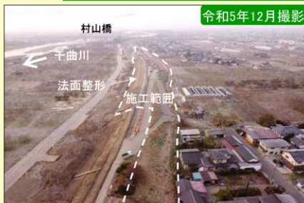
現地施工状況②
