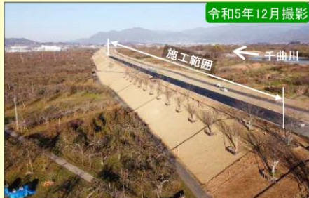
現地施工状況②
