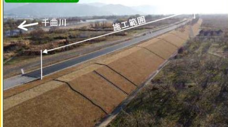
現地施工状況①
