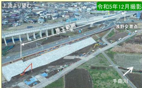
現地施工状況①
