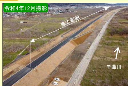
現地施工状況②
