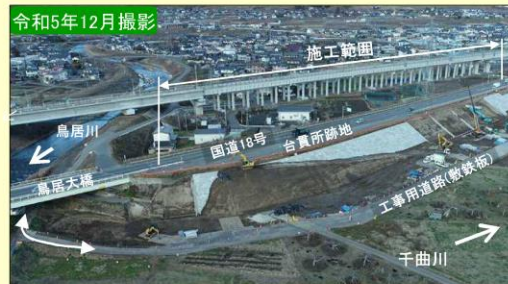
現地施工状況
