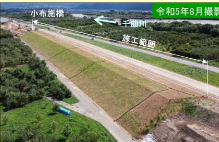
現地施工状況②
