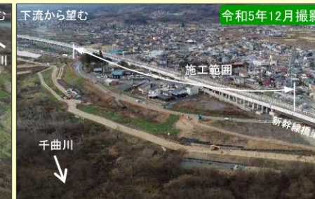
現地施工状況②
