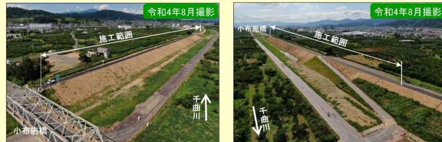
現地施工状況①
