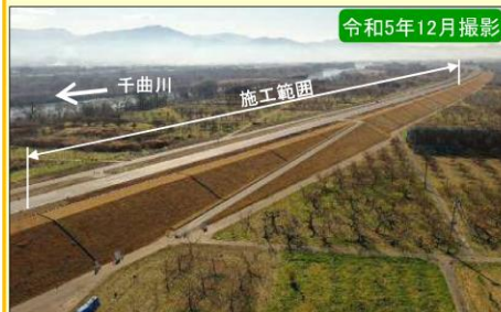
現地施工状況①
