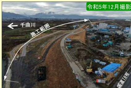
現地施工状況②
