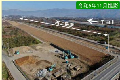
現地施工状況②
