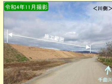
現地施工状況①
