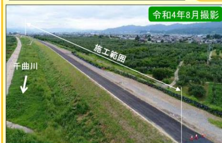
現地施工状況①
