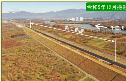
現地施工状況②
