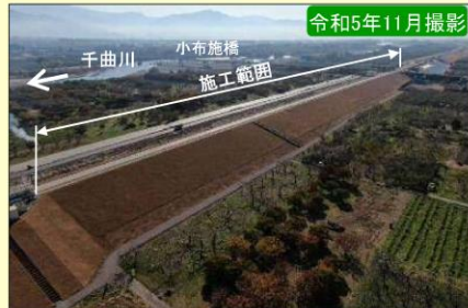
現地施工状況①
