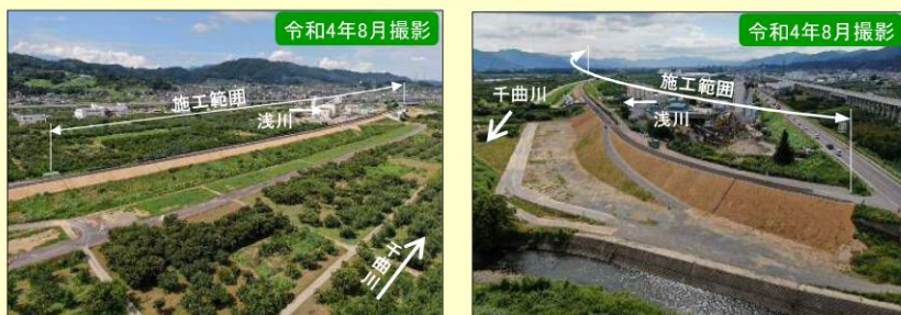
現地施工状況①
