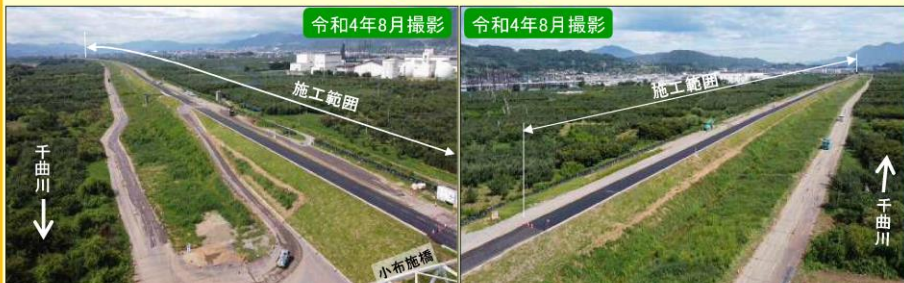
現地施工状況①
