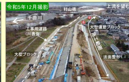
現地施工状況②
