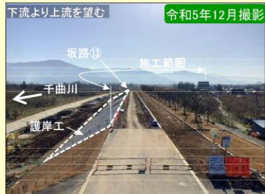
現地施工状況①
