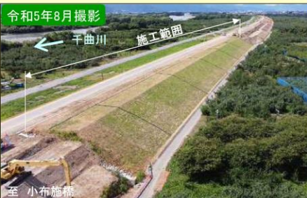
現地施工状況①
