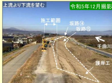
現地施工状況②
