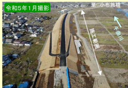
現地施工状況②
