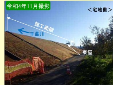
現地施工状況②
