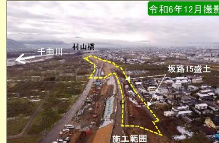
現地施工状況②
