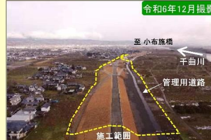
現地施工状況①
