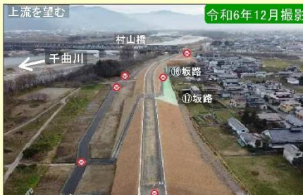
現地施工状況②
