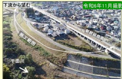
現地施工状況②
