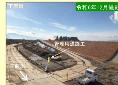
現地施工状況②
