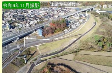
現地施工状況①
