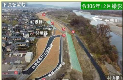
現地施工状況①
