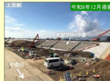
現地施工状況①
