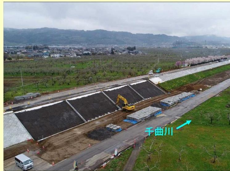
○令和4年1月から川裏側(宅地側)の堤防強化(のり面のコンクリート被覆工事)に着手、現在工事中。
