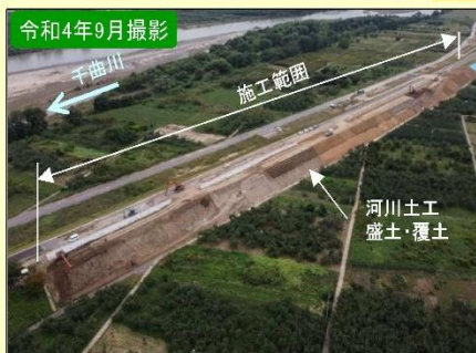
現地施工状況①
