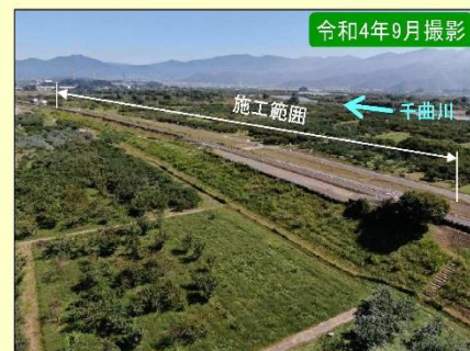
現地施工状況①
