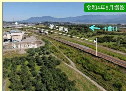
現地施工状況①
