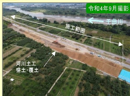
現地施工状況②
