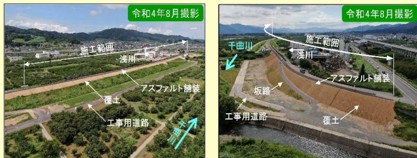
現地施工状況①
