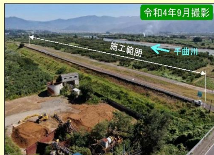
現地施工状況①
