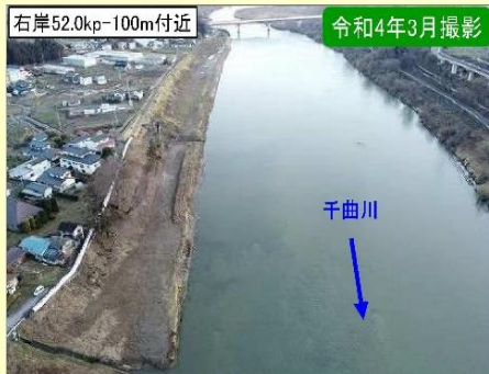
現地施工状況①
