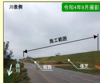
現地施工状況①
