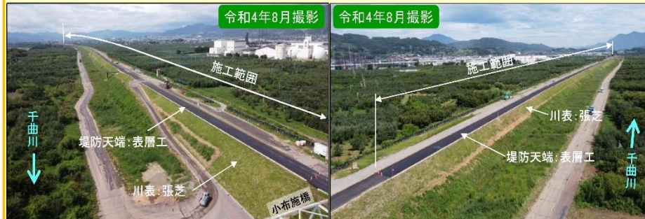
現地施工状況①
