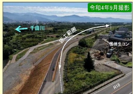
現地施工状況②
