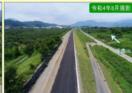
現地施工状況②
