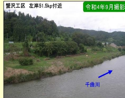
現地施工状況
