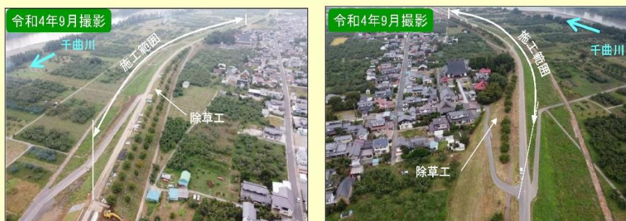
現地施工状況①
