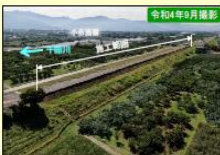
現地施工状況②
