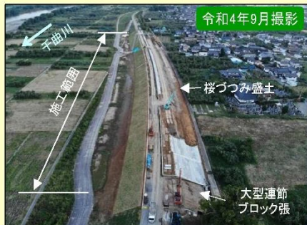
現地施工状況①
