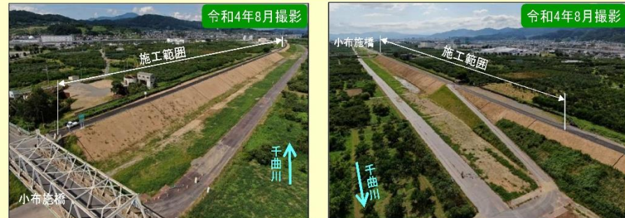
現地施工状況①
