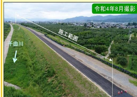
現地施工状況①
