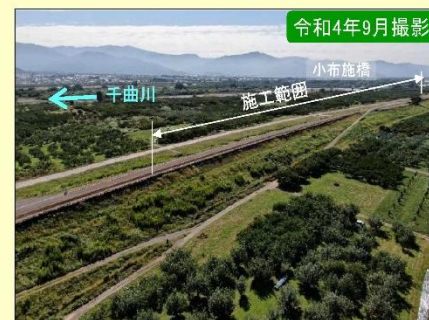
現地施工状況②
