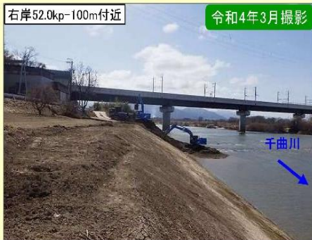
現地施工状況②
