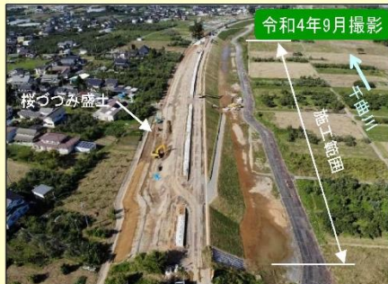
現地施工状況②
