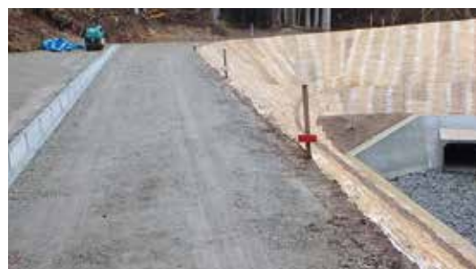
令和3年3月26日竣工 復旧完了
