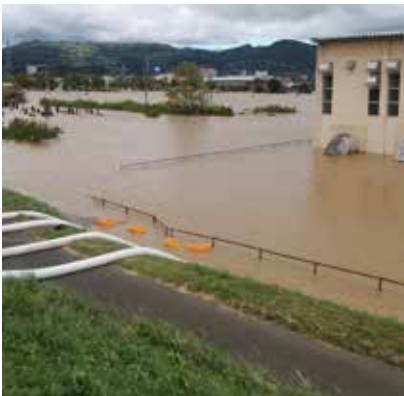
小森第一排水機場の水をポンプ車で外へ
