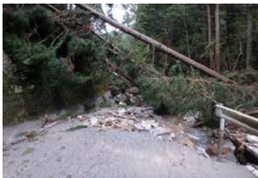
県道長野菅平線(若穂保科)被災後
