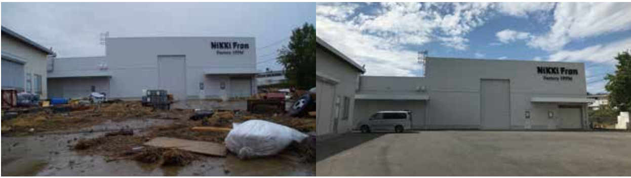
水が引いた後と復旧後の工場外観
