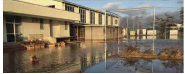
東北中学校校庭の被災状況
