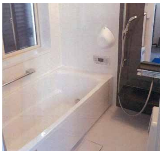
ユニットバス交換完了
