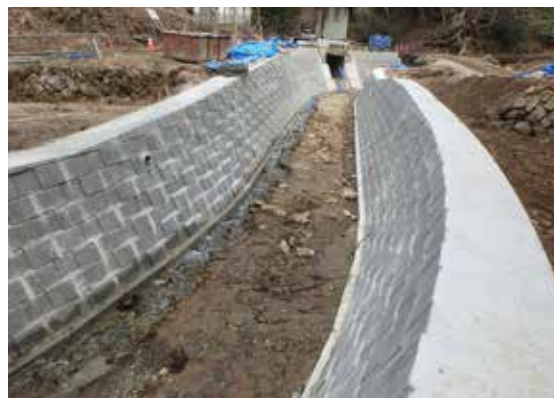
高岡川災害復旧状況(竣工箇所)
