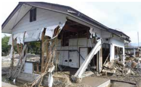
被災した長沼分団詰所
