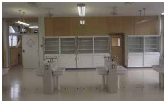
復旧後の理科室
