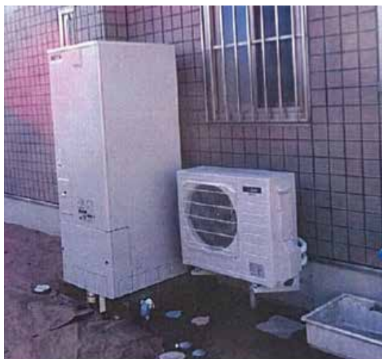
エコキュート交換完了
