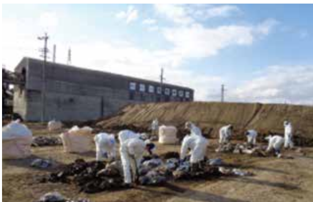
堆積土砂の除去作業
