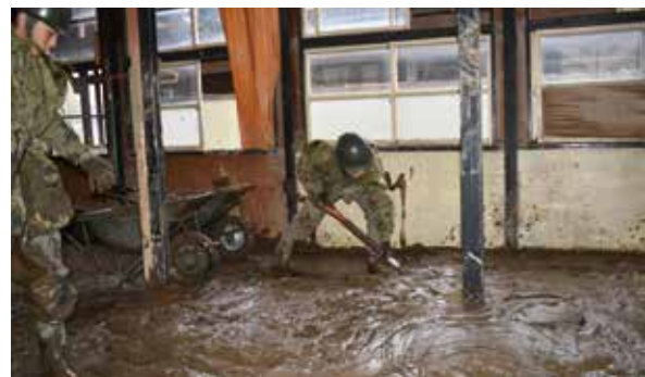
土砂除去作業(長沼小学校)
