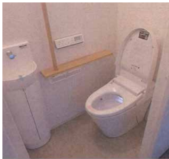
便器交換完了
