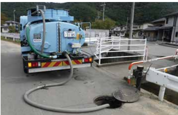
汚水吸引作業
