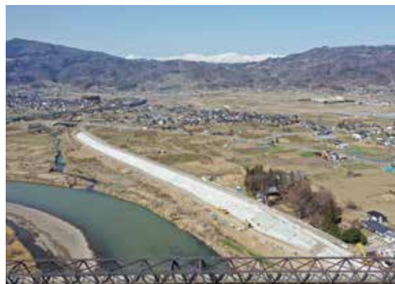
千曲川篠ノ井塩崎地先復旧状況
