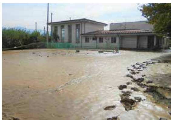
被災直後の建物全景(令和元年10月17日)
