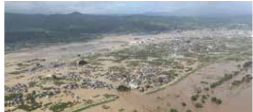
千曲川堤防決壊状況
