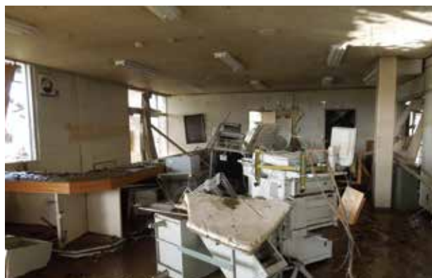
長沼支所事務室（令和元年10月16日）
