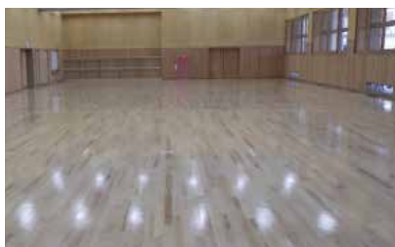
復旧後の武道場
