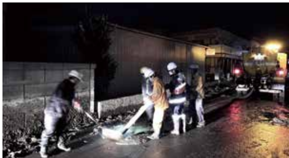
長野県・市の建設業協会が夜を徹して道路の排土作業に当たった (写真提供:新設新聞社)
