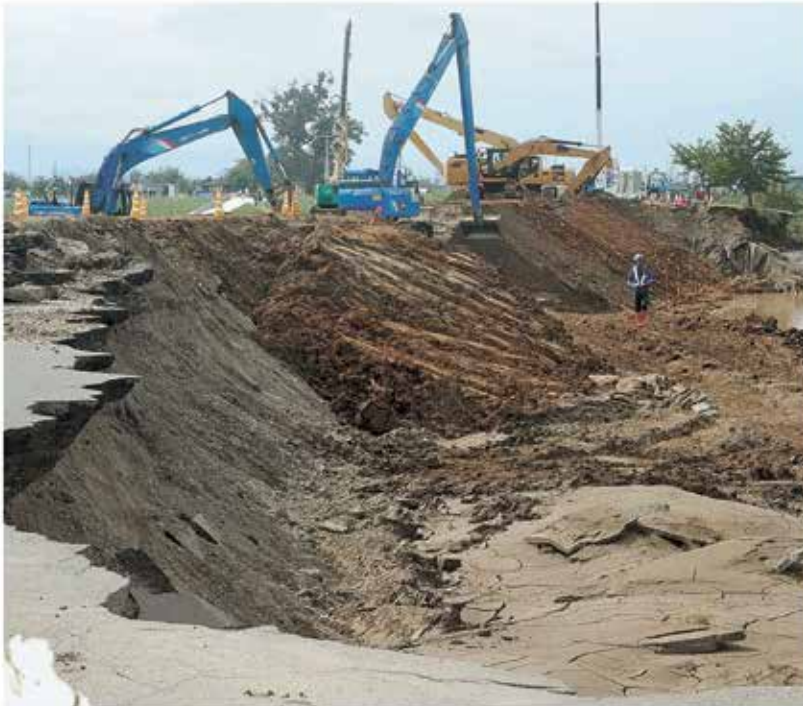
仮堤防完成を目指し、急ピッチで作業が進む千曲川の堤防決壊現場＝17日午前10時36分、長野市穂保
