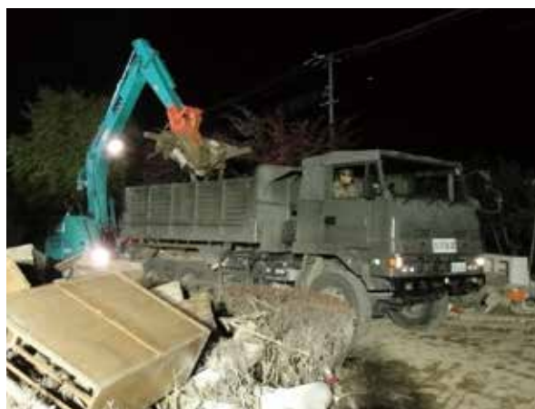
災害廃棄物の撤去(赤沼公園)
