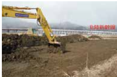
排土作業状況
