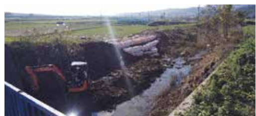
三念沢応急復旧状況
