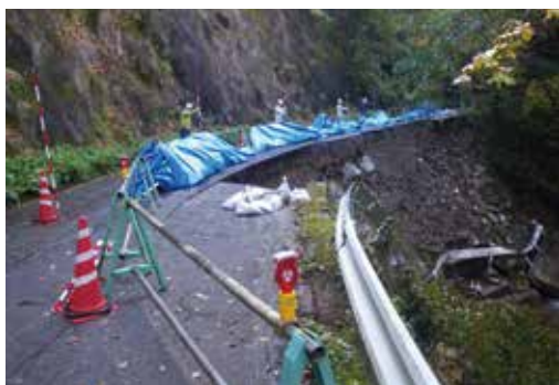
着工前(令和2年4月)
