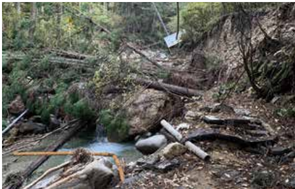
保科では県道長野菅平線が土砂崩落で不通になり、復旧工事は今も続いている
