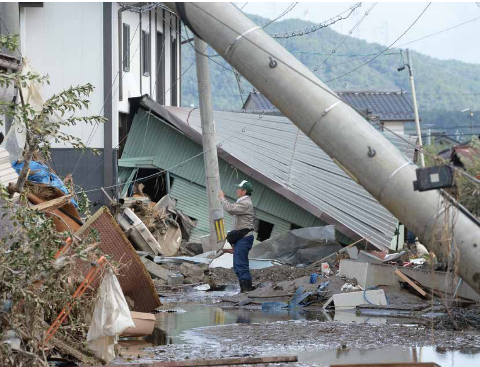
電柱が倒れ、建物がつぶれた穂保（長沼地区）の宅地（令和元年10月15日09時02分、信濃毎日新聞社提供）
