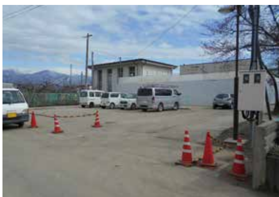
土砂撤去・仮囲い後（令和2年3月31日）
