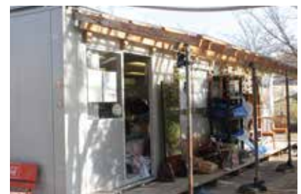
豊野支所駐車場横の公園に移設されたプレハブのぬくぬく亭外観
