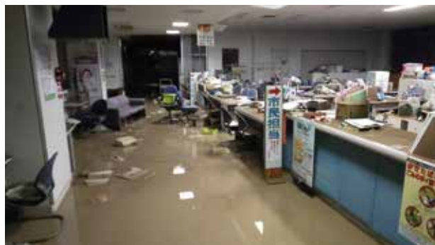
豊野支所1階事務室（令和元年10月13日）
