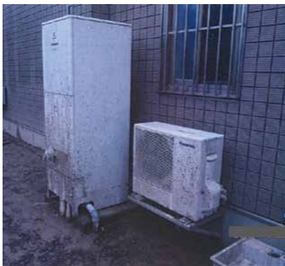
エコキュート交換前
