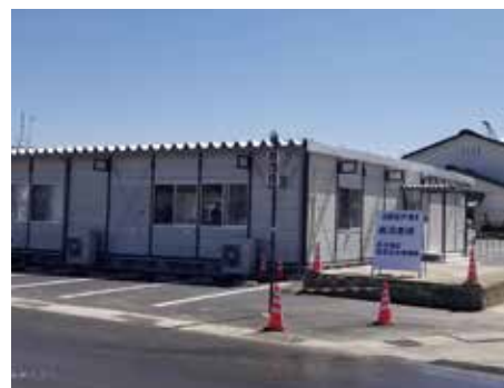
仮復旧した長沼支所
