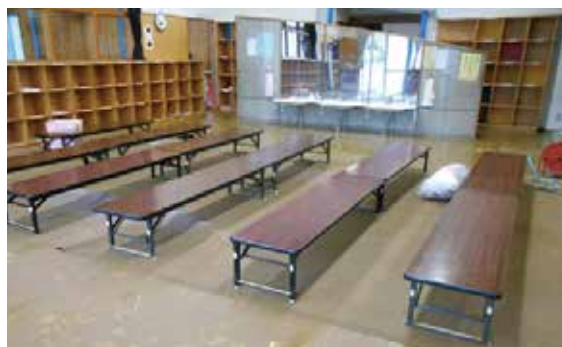
被災直後の集会室(令和元年10月14日)
