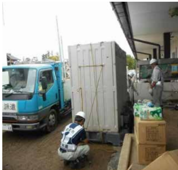
倉敷市から24基の仮設トイレを運搬設置していただいた(長沼支所ほか)
