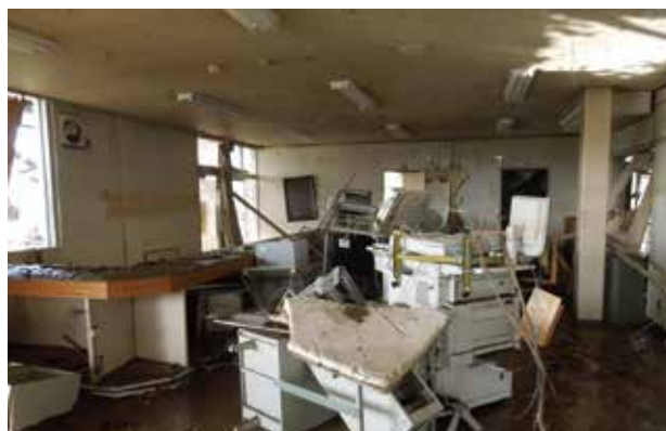
長沼支所事務室（令和元年10月16日）
