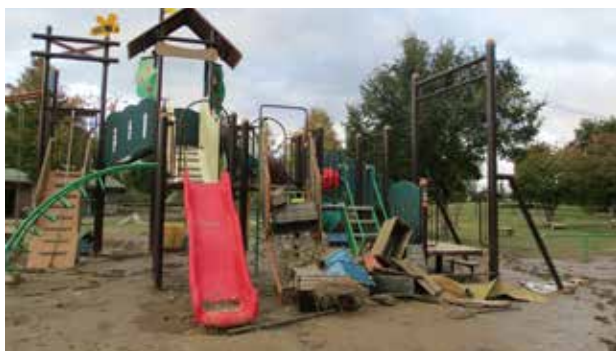
公園施設の浸水被害（被災直後の赤沼公園）
