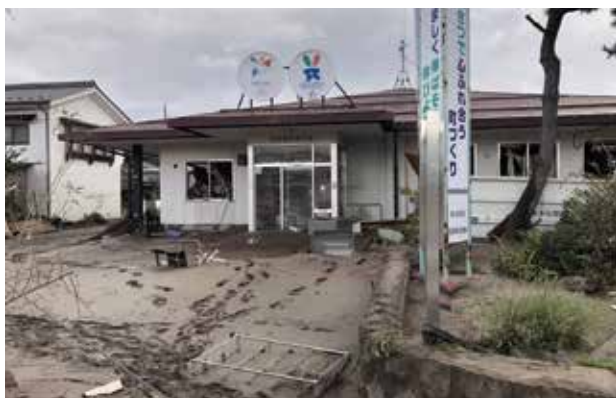
長沼支所正面出入口（令和元年10月15日）
