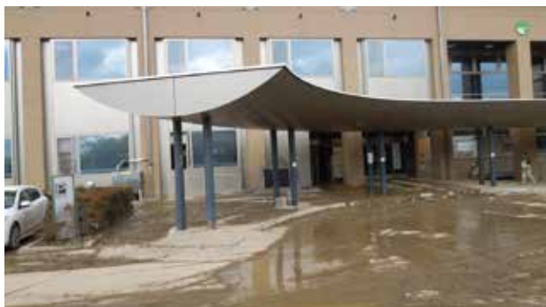
豊野支所正面出入口（令和元年10月15日）
