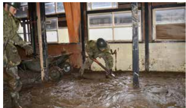
土砂除去作業(長沼小学校)
