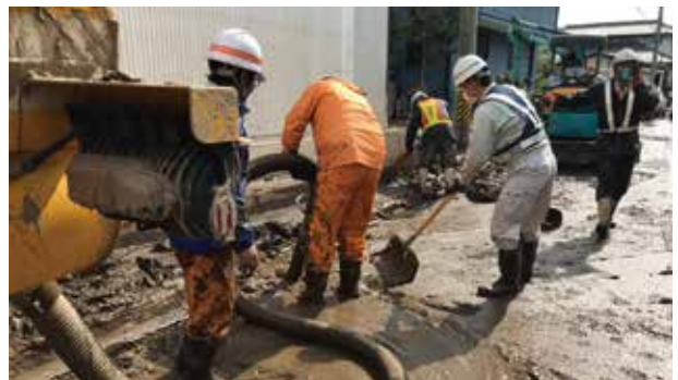
堆積土砂撤去作業
