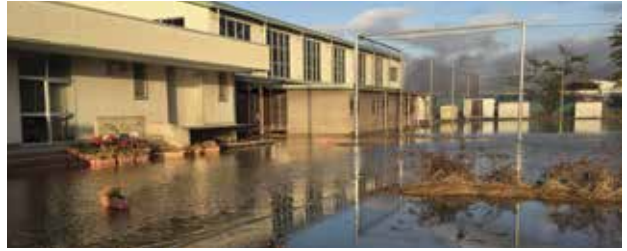
東北中学校校庭の被災状況
