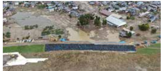
応急仮堤防工事完了状況
