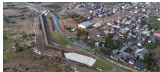
鋼矢板仮締切堤防完了状況
