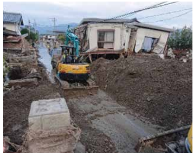
砂撤去作業状況
