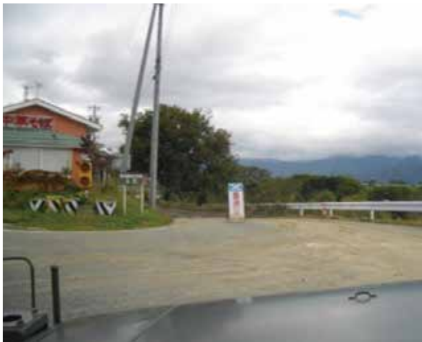
通行困難箇所 通行止め措置
