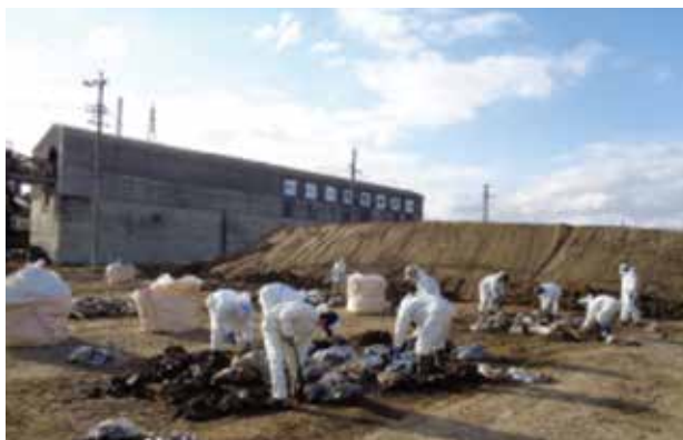
堆積土砂の除去作業
