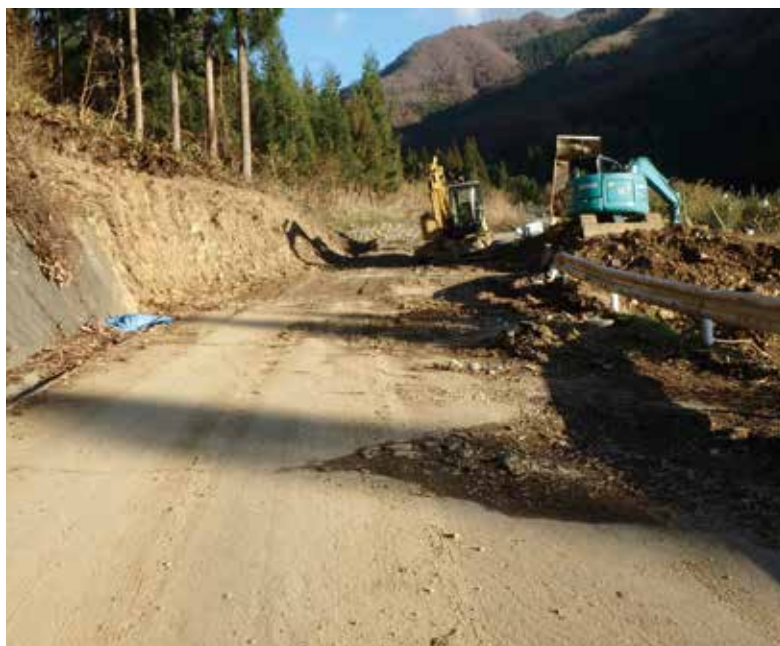
崩落土撤去状況
