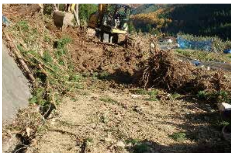
崩落土撤去状況
