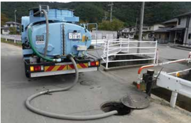
汚水吸引作業
