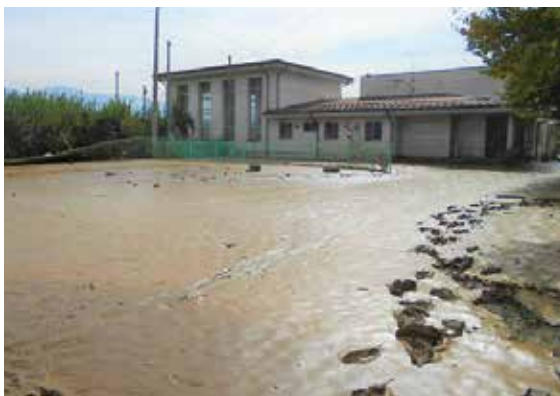
被災直後の建物全景(令和元年10月17日)
