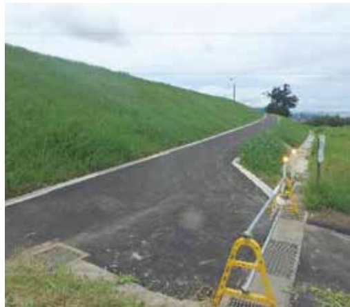
長沼149号線 (穂保) 復旧後
