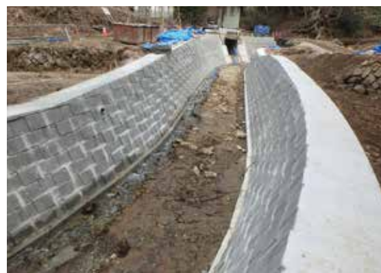
高岡川災害復旧状況(竣工箇所)
