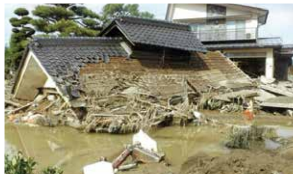
被災した農業用倉庫
