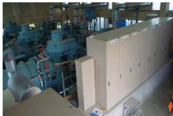
小森第一排水機場 制御盤等の復旧状況
