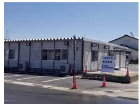
仮復旧した長沼支所
