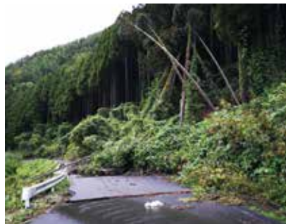
高岡の土砂崩落、山間地の道路はいたるところで寸断された
