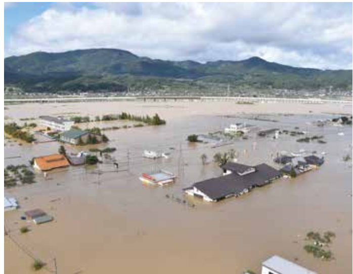
令和元年10月13日、長沼地区のほとんどが水に浸かった(写真左手に長沼小学校)
