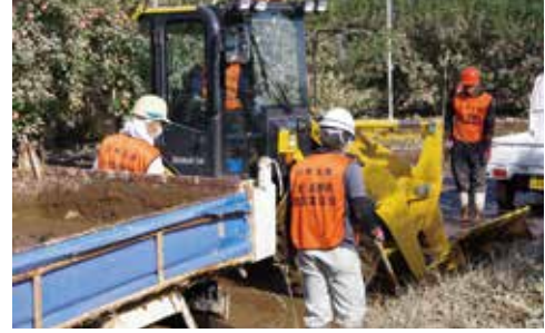
長野県建設業協会各支部による土砂撤去(新建新聞社提供)
