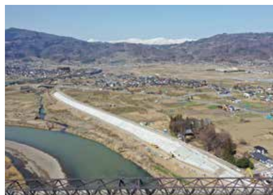
千曲川篠ノ井塩崎地先復旧状況
