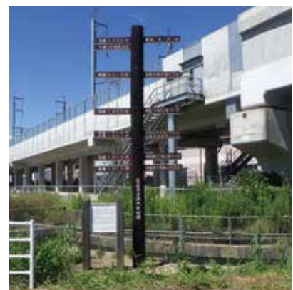
令和2年8月、赤沼に完成した新しい善光寺平洪水水位標、令和元年の水位は上から2番目
