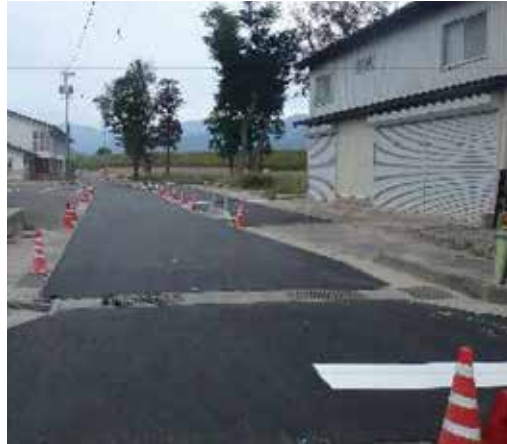
長沼94号線 (穂保) 復旧後
