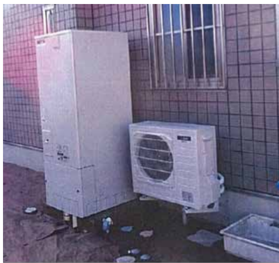
エコキュート交換完了
