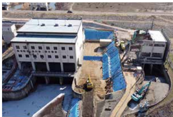
浅川第一排水機場の復旧状況(施工中)
