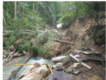
持者の崩落現場
