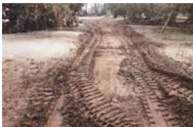
被災直後の堆積土の状況
