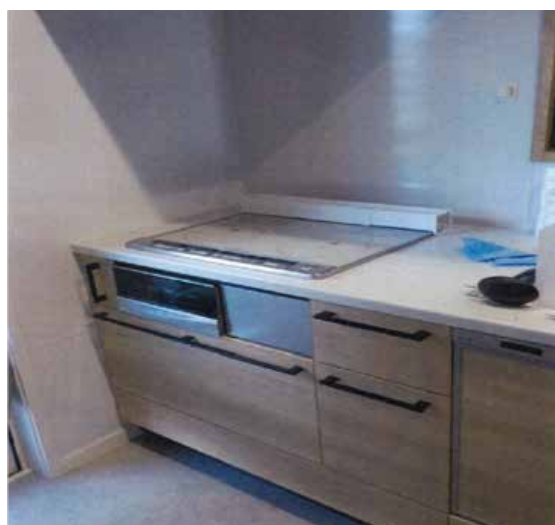
流し台交換完了
