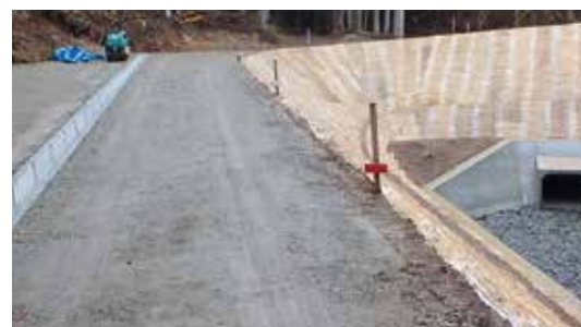
令和3年3月26日竣工 復旧完了
