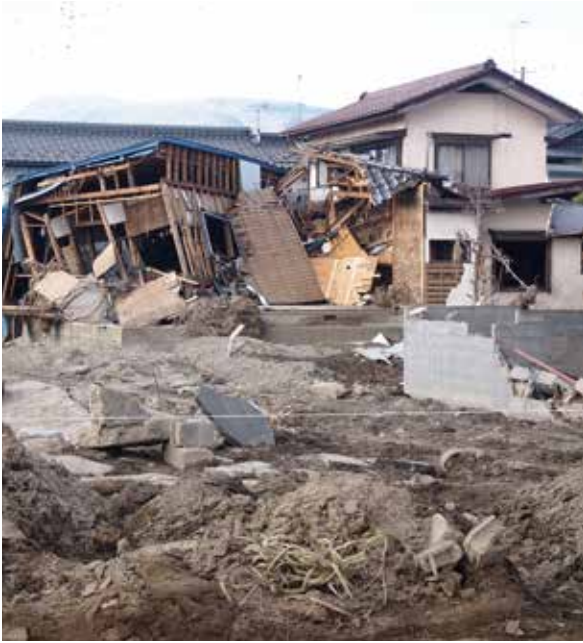
被害が大きかった津野・穂保付近
