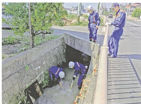
消防水利 (取水ピット) 点検調査 清掃
