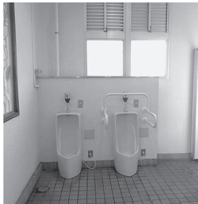
鍋屋田小東側のトイレ(ピカピカです)
