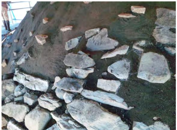
石の下に大きく空洞がある部分は、補強の石を咬ませて補強し、崩落の危険性のある石については、見えないところで補強した。また、ずり落ちている石については仕上げとなる擬土の内側に押し込んだ。
