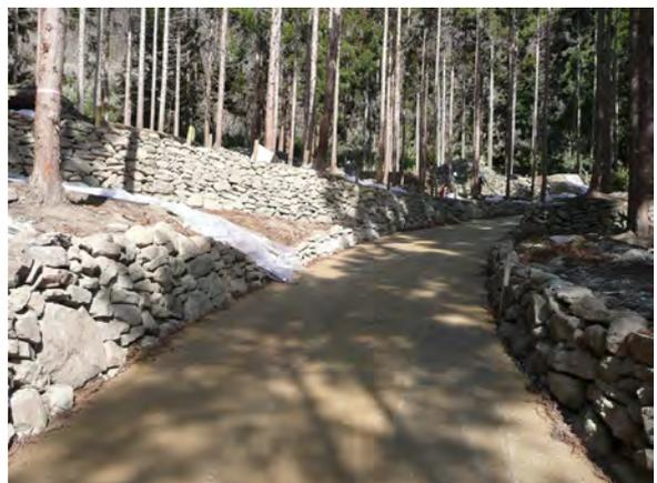
認したところ、石垣が比較的高く積まれている部分では、園路脇に法を設けるには大掛かりな造成が必要となる場所が発生した。この段差解消に関しては、現地発生石材を利用して、周辺地と同様に石垣を積んで、地形の改変をできる限り小さくする方法で納めることとした。脱色アスファルト舗装部の施工はA・B区環境整備工事と同様の仕様で施工を行った。
