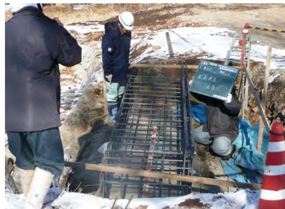
ため、橋台コンクリートを打設後不織布や裏込材、天端コンクリートを復旧することとして施工を行った。
