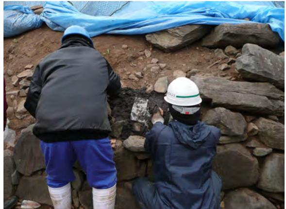
北面の表土が流出していると判断される場所については、緩んだ表土を厚めに鋤取り、土石混合の仕上げ面が既存石垣面より前面にせり出さないようにし、天井石の上部の土砂も同様に鋤取った。
