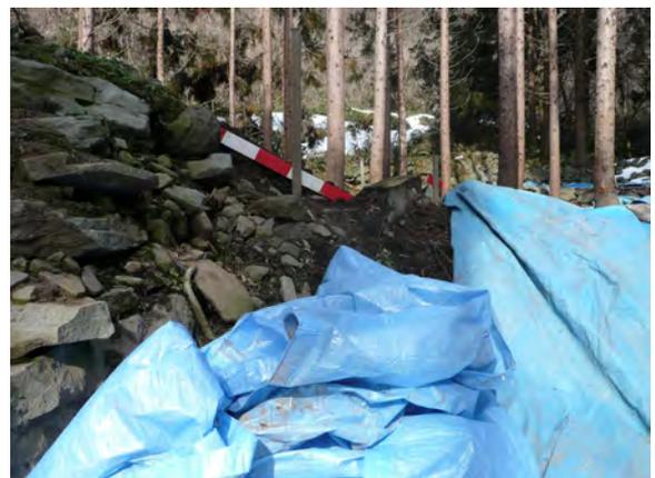
盛土は天井石が半分隠れる高さを最高高さとし、ここから1：2.0の勾配で法面を形成するように設定した。盛土は1層の仕上り厚み20cmとなるように撒きだしを行いタンパやタコ、土羽板等で十分に締め固め、層状盛土とした。特に石室に近接する部分ではタコ等による転圧時に石材に影響を及ぼすことがないように、また、石室に変異が生じないか確認しながら丁寧に行った。
