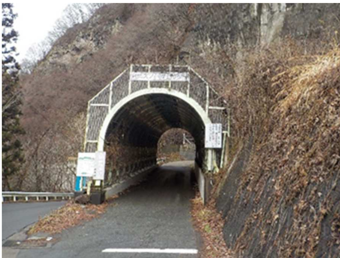
沢尻スノーシェッド（長野市入山）
