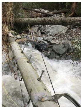
豪雨による道路状況
