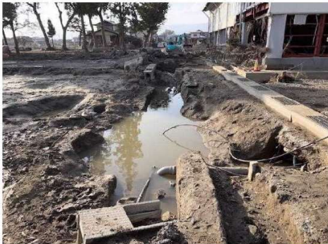
豪雨による道路状況
