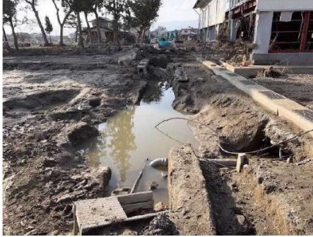
豪雨による道路状況
