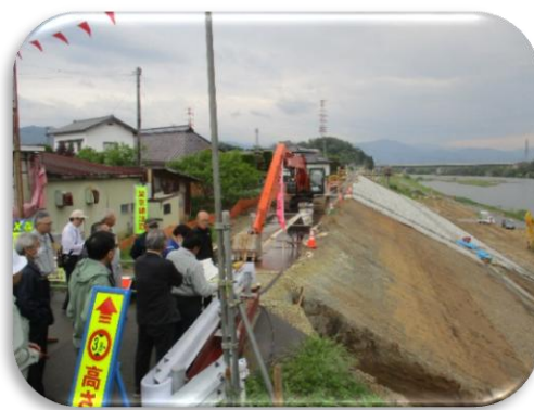
立ヶ花狹窄部 河道掘削 視察
