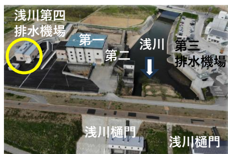
【浅川第四排水機場 配置状況】
