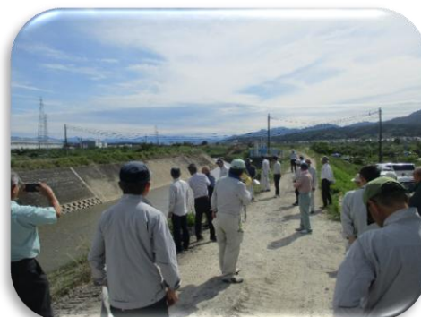
大道橋付近 浅川浚渫状況 視察
