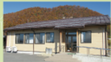
研修センター 研修棟
