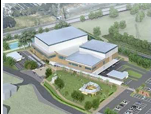
画像：袋井市総合体育館ホームページより
