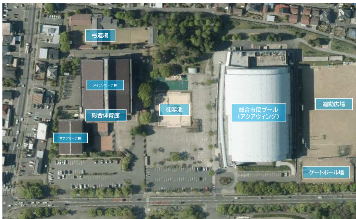
図 4-4 長野運動公園北側敷地航空写真
