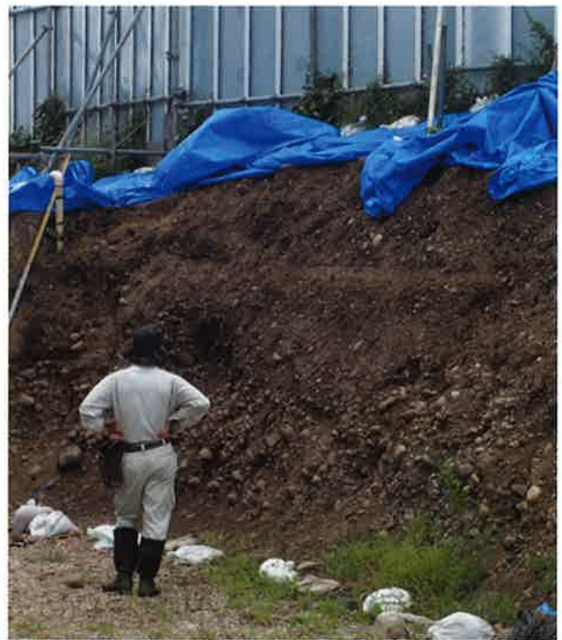
図7 県立大学建設時に見られた地下の様子。多くの砂や石が見られる。
