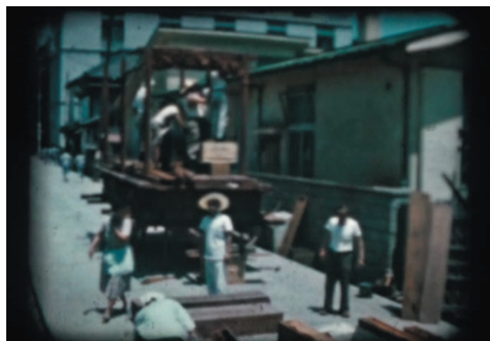
写真7 屋台の組み立て（8mm フィルム映像より）
