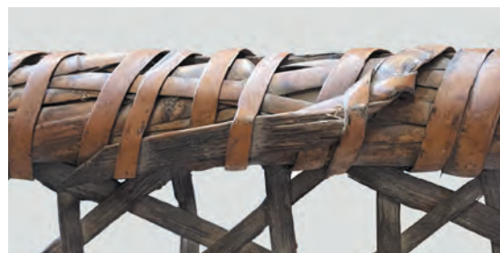
写真2 コンピラツギの例
