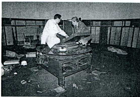
解体される旧プラネタリウム
