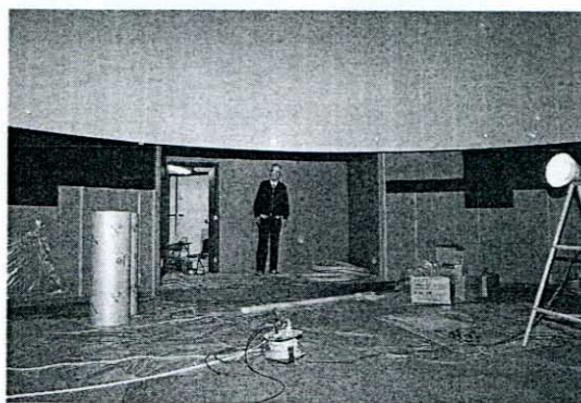
内装工事も完成間近
