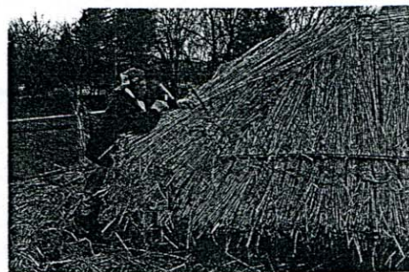
▲葺き替え中 軒の麻殻とトイ棒、真竹の押鉾が見える
