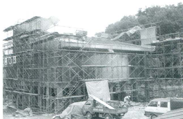
▲建設中の自然史館（昭和60年6月）
