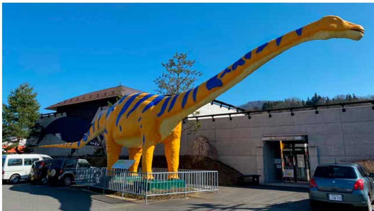
図11 塗装工事が完了した「でいぷろん」 2019年10月30日
