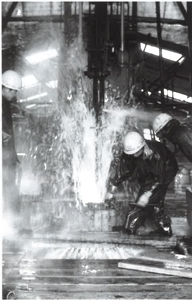
図5 ボーリング調査により温泉が噴き出した。
