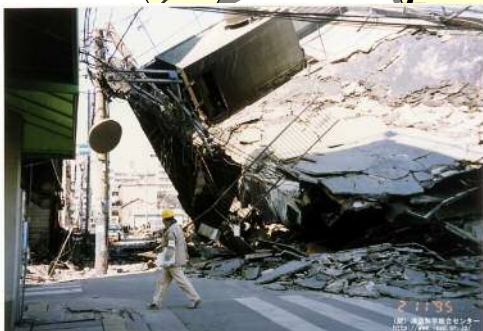
沿道建築物の倒壊による道路閉塞(阪神・淡路大震災)
