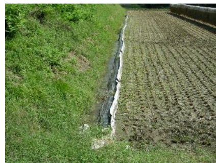
栃倉地区の水田山側に設けられた排水溝(平成22年9月14日撮影)
