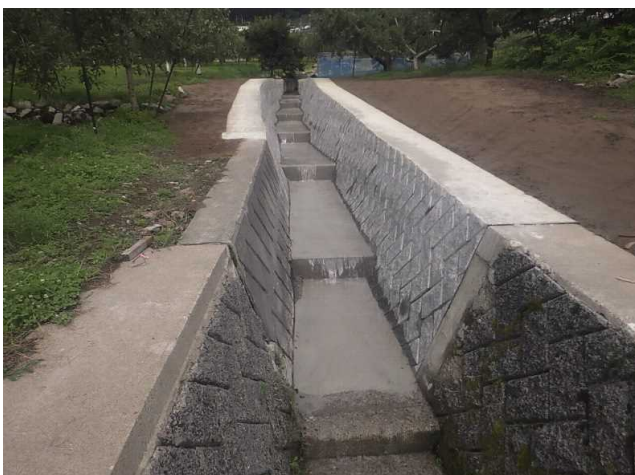
災害復旧工事後(下流側)
