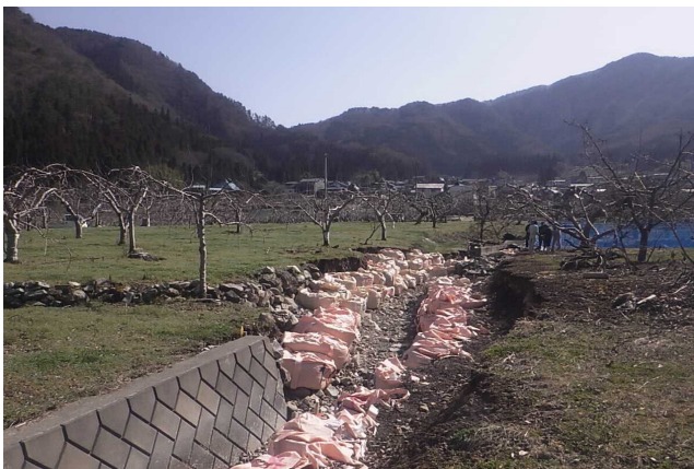
災害復旧工事前(下流側)
