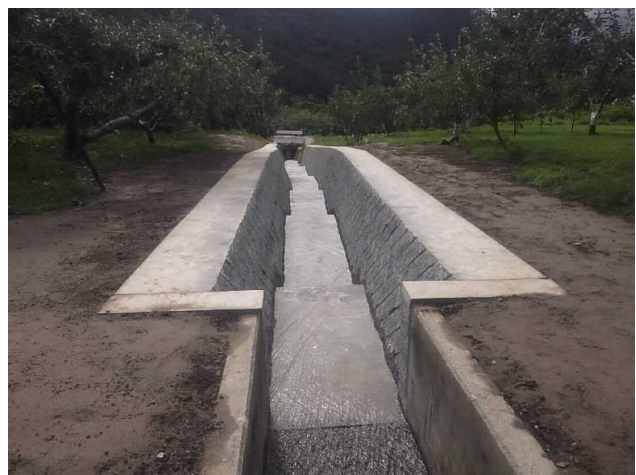
災害復旧工事後(上流側)
