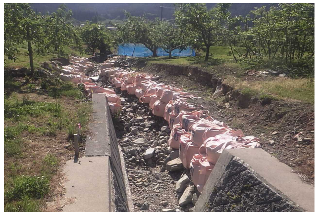
災害復旧工事前(上流側)
