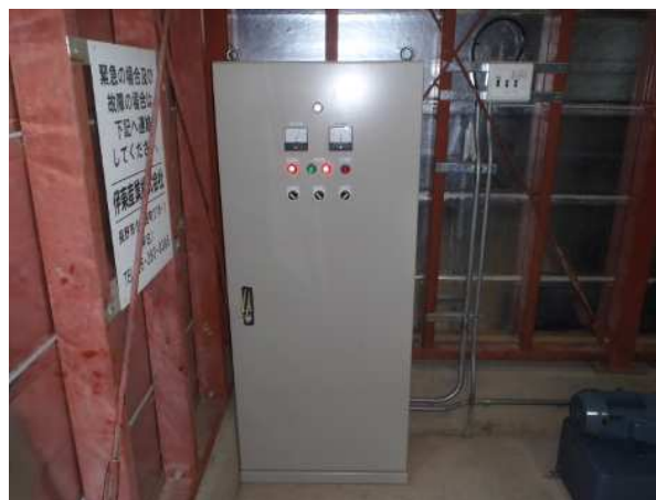
復旧した制御盤
