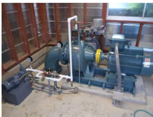
復旧したポンプ
