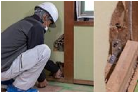
例) 必要最小限の壁を撤去し、補強金物を取り付け
