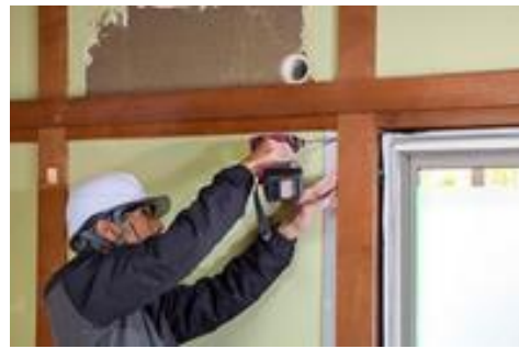
例) 壁を解体せず、金物で構造用合板を取り付け
