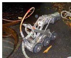
管渠内部を写すテレビカメラ
