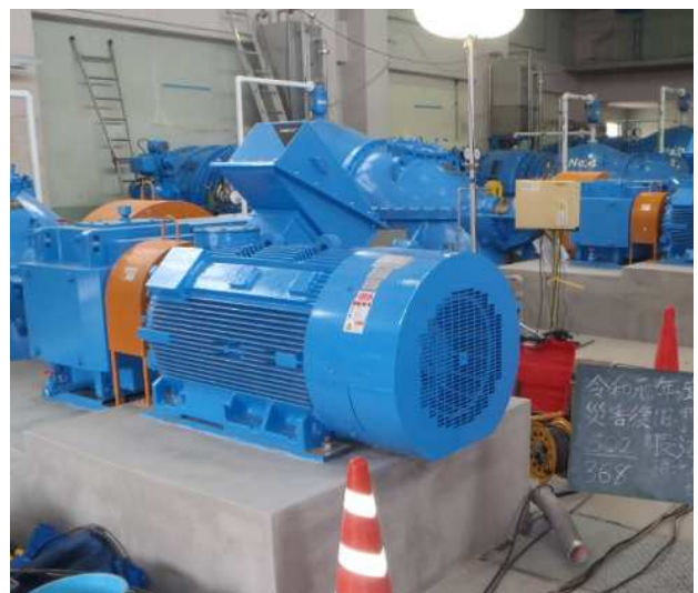
復旧したポンプ(電動駆動)
