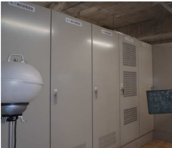
復旧した制御盤施設
