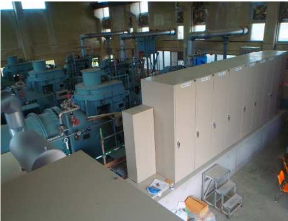
嵩上げ工が完成した制御盤
