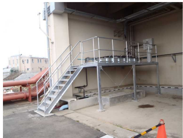
補器類嵩上げ状況
