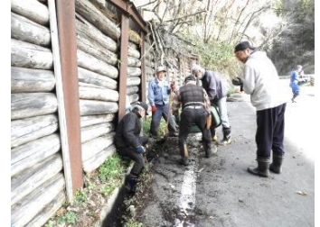
U字溝の泥揚げ
