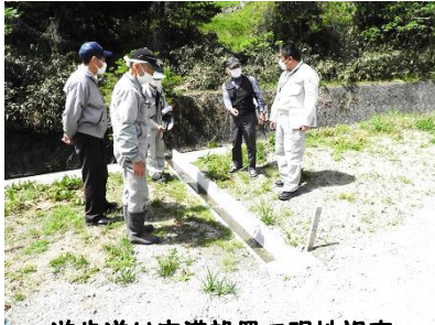
遊歩道U字溝設置で現地調査
