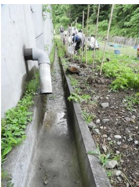
土砂除去したU字溝
