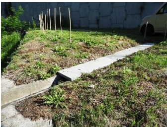
設置されたU字溝のフタ
